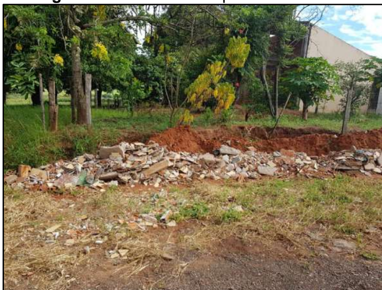
Figura 19 – Uso de RCC para evitar erosão
